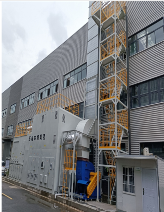
四级干式过滤+沸石转轮浓缩+催化氧化设备 (CO) 有机废气处理设备
